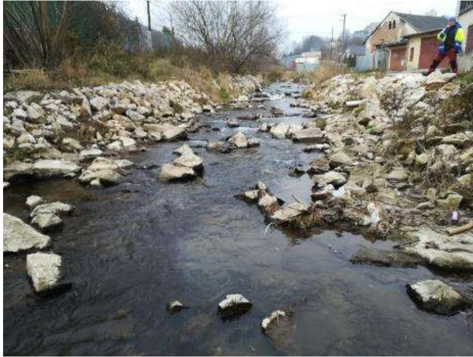
Levočský potok v Levoči - po odbúraní dvoch vodných skokov a doplnení kamenných výhonov
