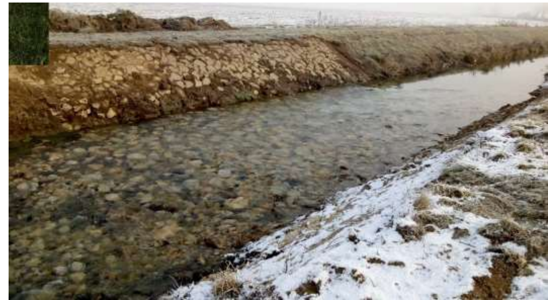
Bodva pri Budulove – odstránenie stavidla
